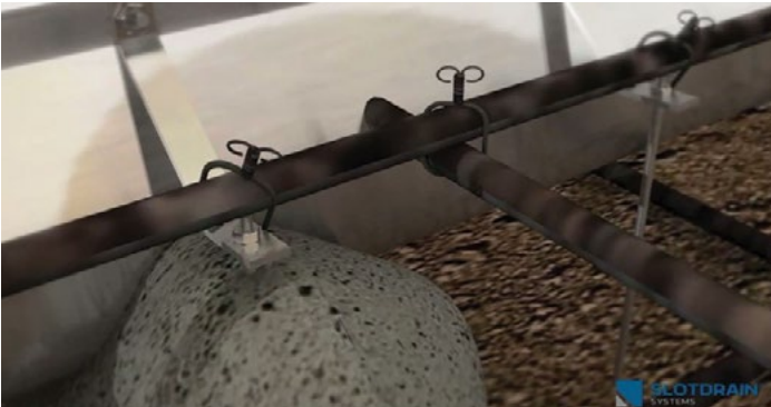
POUR SLURRY BELOW TO SECURE THE DRAIN
